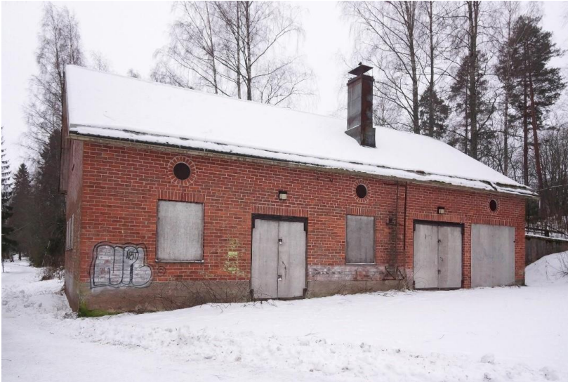
Liite 1.5 Kolsan vanhan maatilan autotallirakennus
